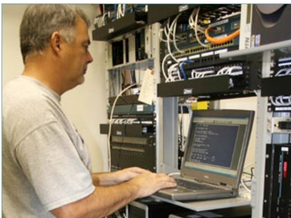
Le workstation sono connesse in remoto a Extio tramite un unico cavo in fibra ottica.
