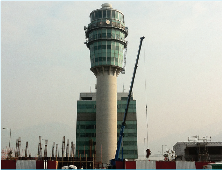
Maevox proporciona a las oficinas del Departamento de Aviación Civil de Hong Kong imágenes de las vistas de la torre de control de tráfico aéreo del aeropuerto a través de una cámara.
